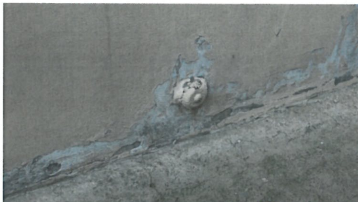
Zdj.11. Stary reper geodezyjny na ścianie zachodniej
