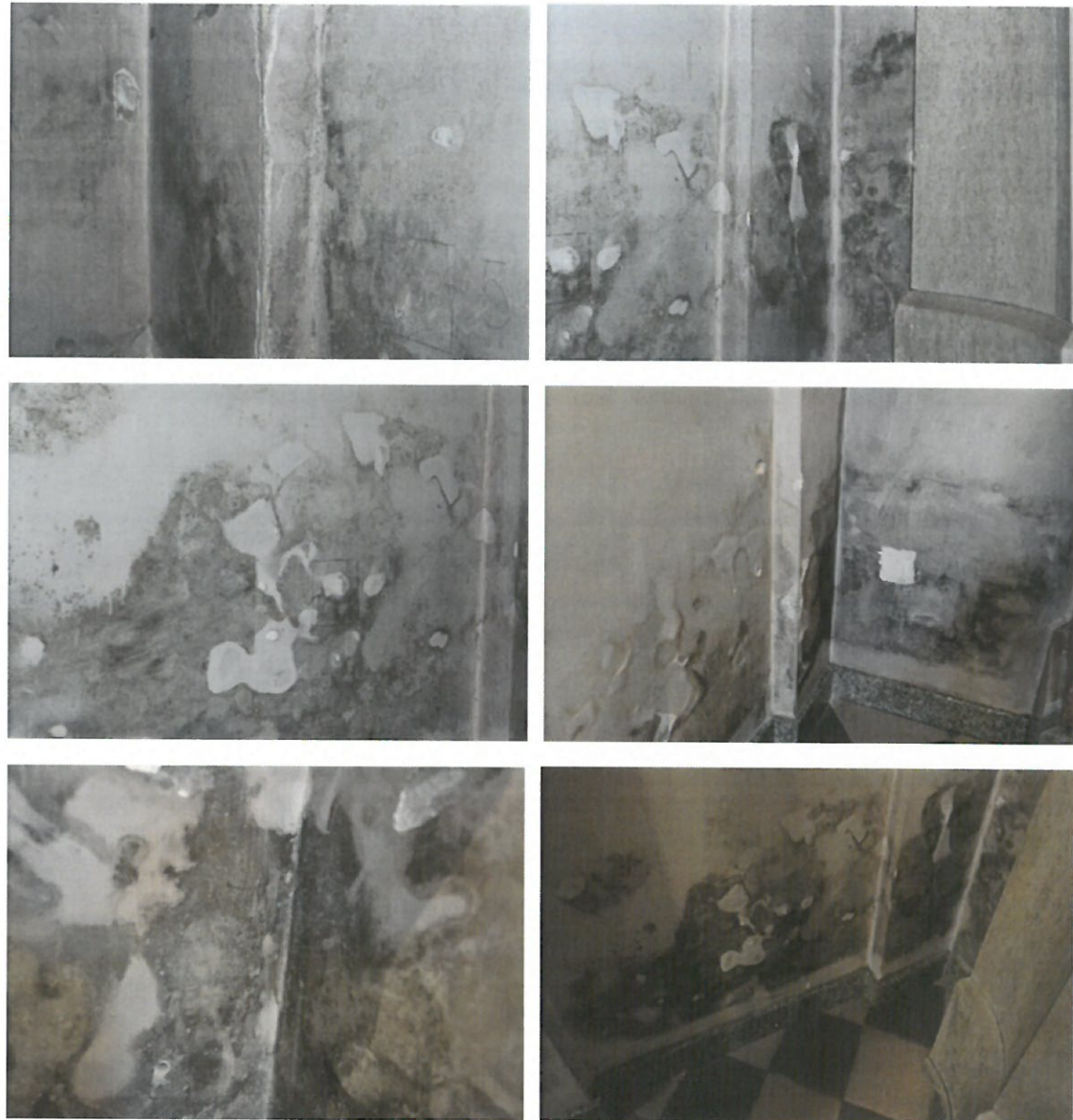
Zdj. 5. Widok stanu zagrzybienia ścian kościoła ponad posadzką nawy – ściana wschodnia i zachodnia
