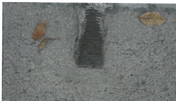
Zdj.4. Fragment ściagu na ścianie zachodniej. Jest to jedyny ściąg widoczny wzdłuż przebiegu ścian zewnętrznych kościoła
