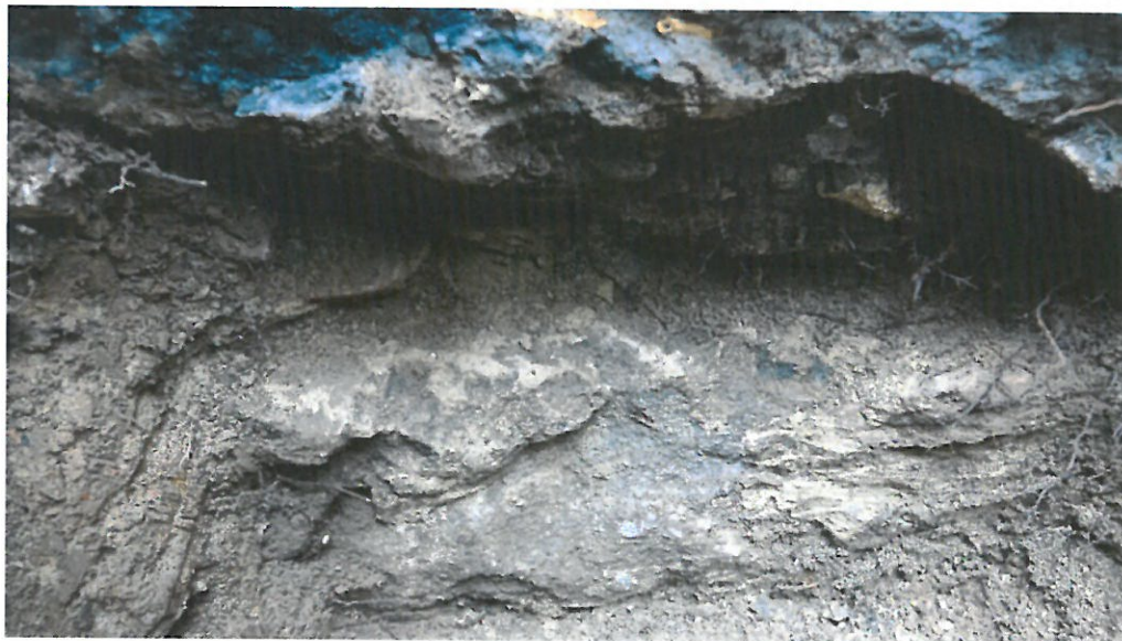
Zdj.9. Nieregularne ciosy kamienne stanowiące ścianę fundamentową elewacji wschodniej znajdujące się pod wzmacniającą konstrukcją opaską betonową
