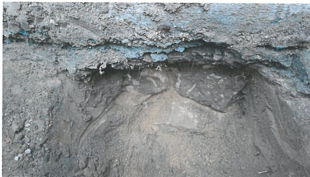
Zdj. 10. Ciosy kamienne ściany fundamentowej zachodniej
